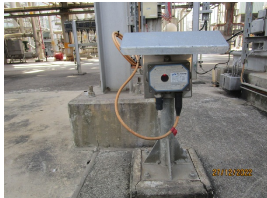
รูปที่ 54 Gas Detector
