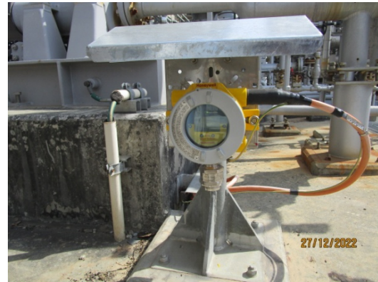
รูปที่ 66 ระบบตรวจจักษ์ก๊าซที่มีความเป็นพิษ (Toxic Gas Detector)
