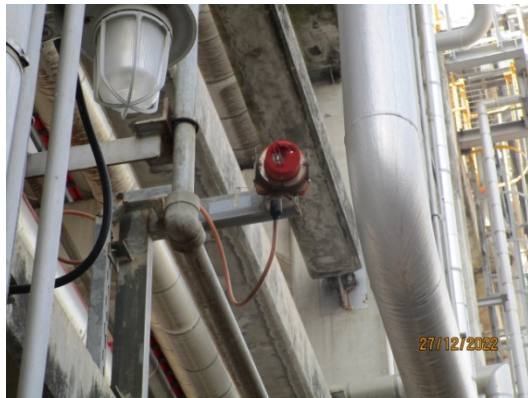
รูปที่ 53 Flame Detector
