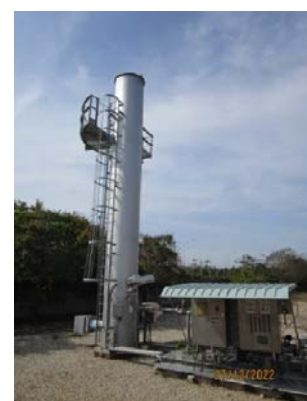
รูปที่ 34 หน่วยกำจัดไอไฮโดรคาร์บอน ในระบบบำบัดน้ำเสีย (Vapor Disposal Unit)
