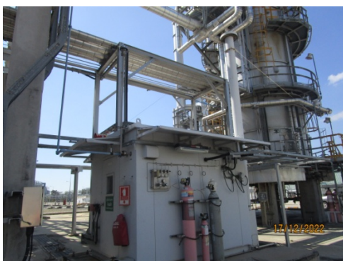
รูปที่ 2 อุปกรณ์ตรวจวัดการระบาย สารมลพิษจากปล่องอัดโนมัติ (CEMs)
