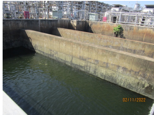
รูปที่ 30 Final Effluent Basin (2930-XC 20)
