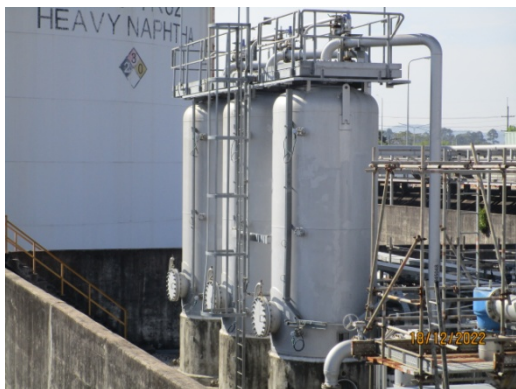
รูปที่ 5 หน่วยนำกลับไอสารไฮโดรคาร์บอนจากถังเก็บกัก (Vapor Recovery Unit : VRU)
