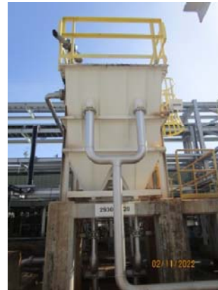
รูปที่ 24 หน่วยแยกน้ำออกจากน้ำมัน (CPI) (2930-TK20) ของ New ETP
