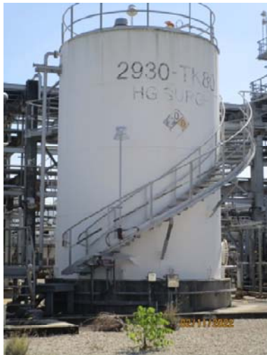
รูปที่ 17 ถังพักน้ำทิ้งปนเปื้อนปรอท (2930-TK80)
