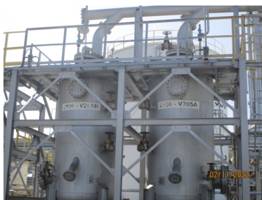
รูปที่ 33 ระบบบำบัดไอไฮโดรคาร์บอนจาก Holding Basin (Vapor Adsorber (2930-V205A/B))
