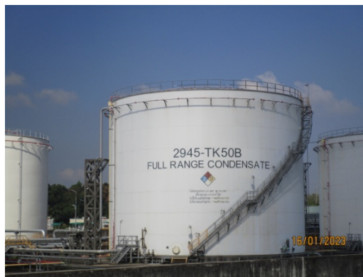
รูปที่ 6 ถังสำรองสารไฮโดรคาร์บอน ที่ระเหยง่ายเป็นชนิด IFRN
