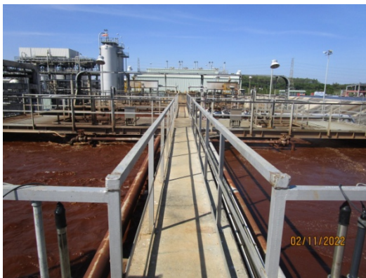
รูปที่ 19 ระบบบำบัดน้ำเสียรวมของโรงงาน แบบ Activated Sludge
