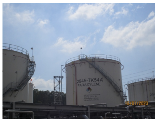
รูปที่ 8 ถังสำรองสารไฮโดรคาร์บอนทั่วไป เป็นชนิด CRN
